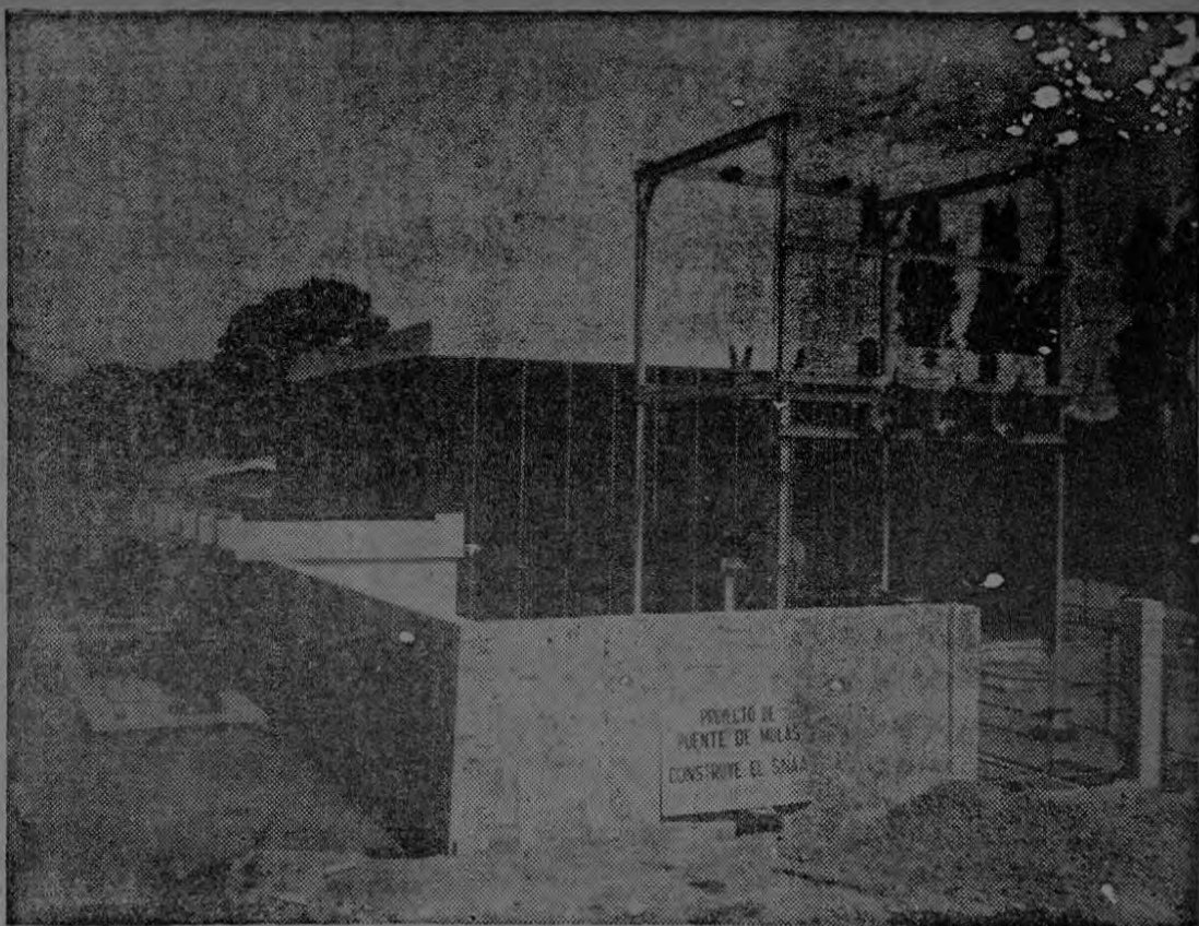
Edificio de la estación de bombeo N° 2 del proyecto de Puente de Mulas, construido en San Rafael de Escazú.
