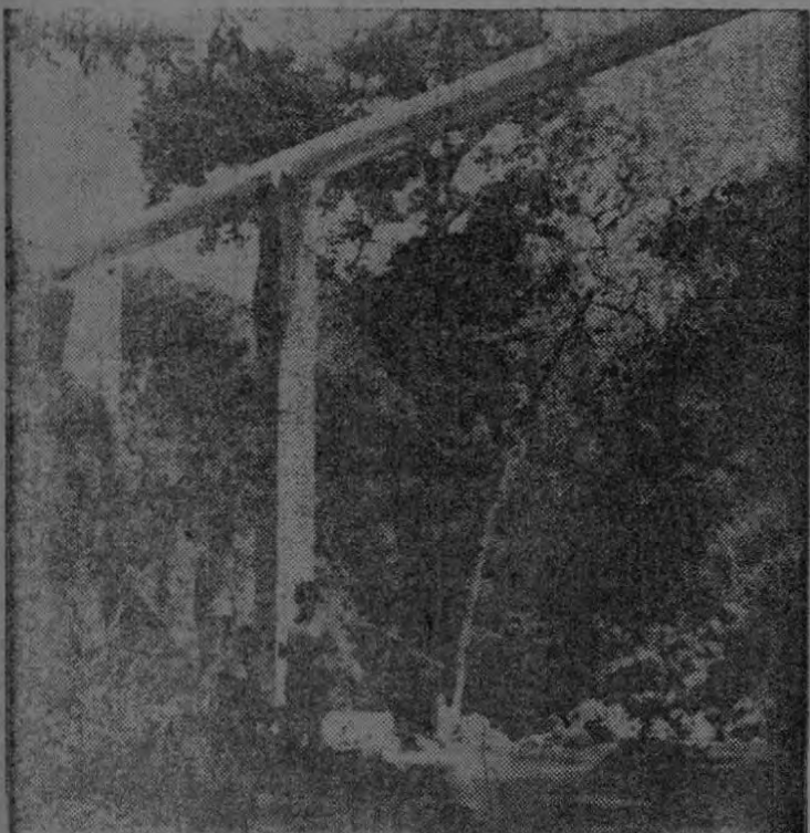
Puente construido para el paso de la tubería de conducción sobre la quebrada de Las Yeguas. En total fueron construidos once puentes.
